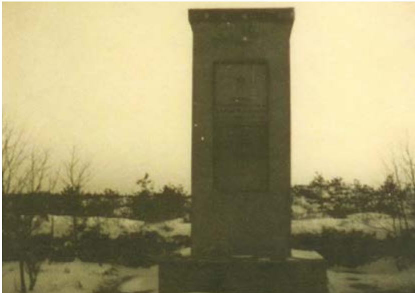
Abb. 1: Foto des Ehrenmals auf der Grabstätte für sowjetische Kriegsgefangene in Gudendorf zwischen 1945 und 1958, private Sammlung von Benno Stahn.
